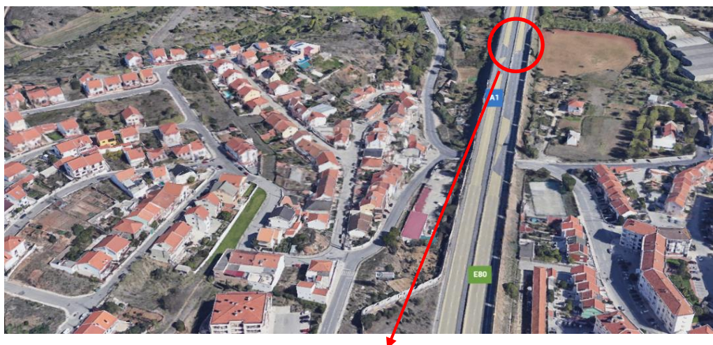
Construção nó de acesso para A1
